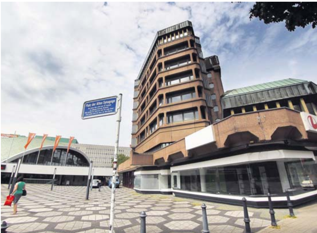
Auch die imposante Immobilie am Hansaplatz wird derzeit saniert. Hier sollen schon bald hochwertige Wohnungen und Gewerbeflächen angeboten werden.
